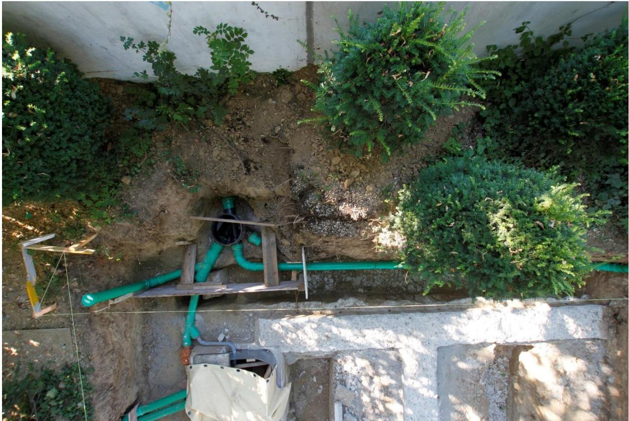
Die bestehende Abwasseranlage wurde erneuert. Hier ein Überblick über die alten Fundamente, den Aushuböffnungen für die neuen Fundamente und die Abwasserleitungen.
